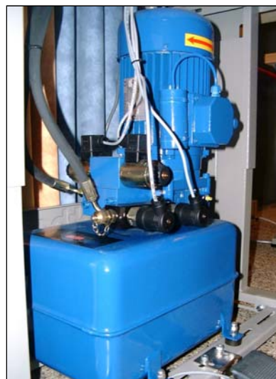
Figure 19 Inspection complète de l'agrégat
